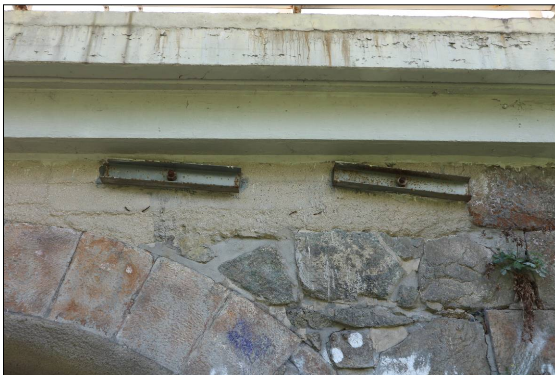
Obr. č. 11 - detail zhlaví kotev na pravé straně objektu, v čele nad klenbou
