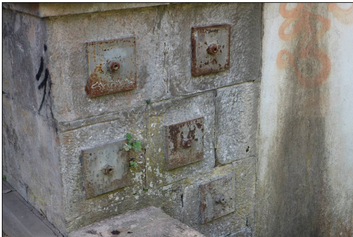
Obr. č. 10 - pohled na pravou stranu opěry Blansko - zhlaví kotev, PKO za hranou životnosti a opadává, v místech opadů povrchová koroze
